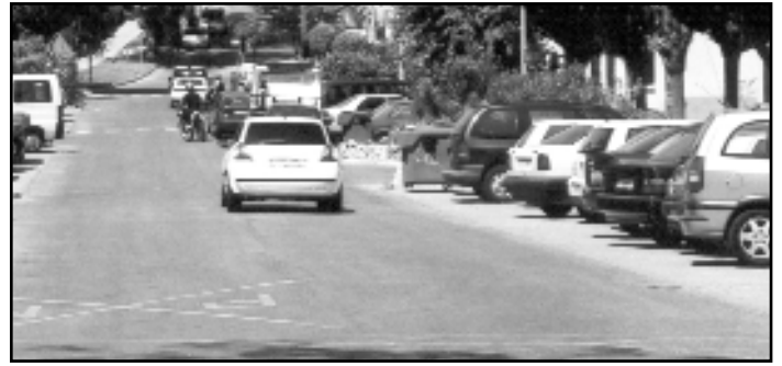
La avenida de la Constitución será una de las vías bajo las que discurrirá el nuevo colector de Azuqueca.
