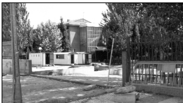
Los institutos Arcipreste de Hita y San Isidro tienen nueva rampa
